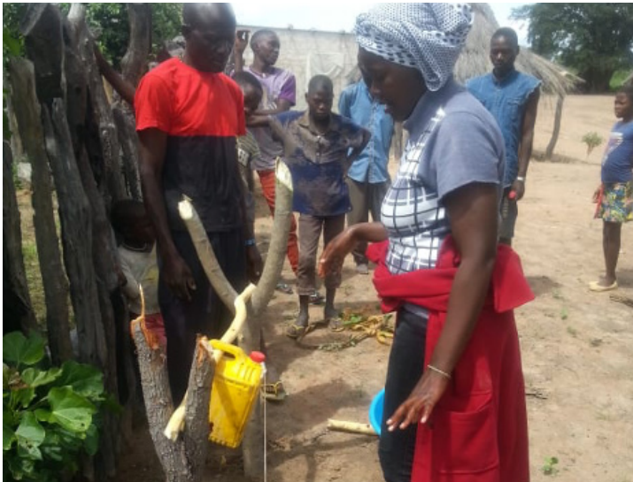
Montagem e demonstração de sistema de Tippy -tap para lavar as mãos
